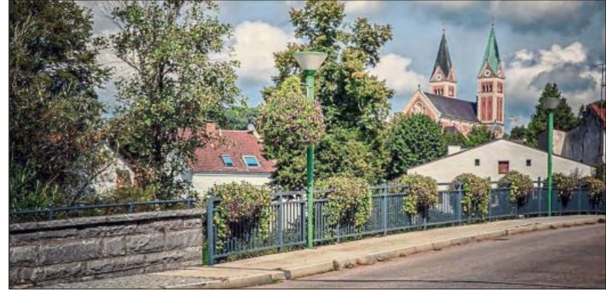
... und heute die Florian-Geyer-Brücke.
