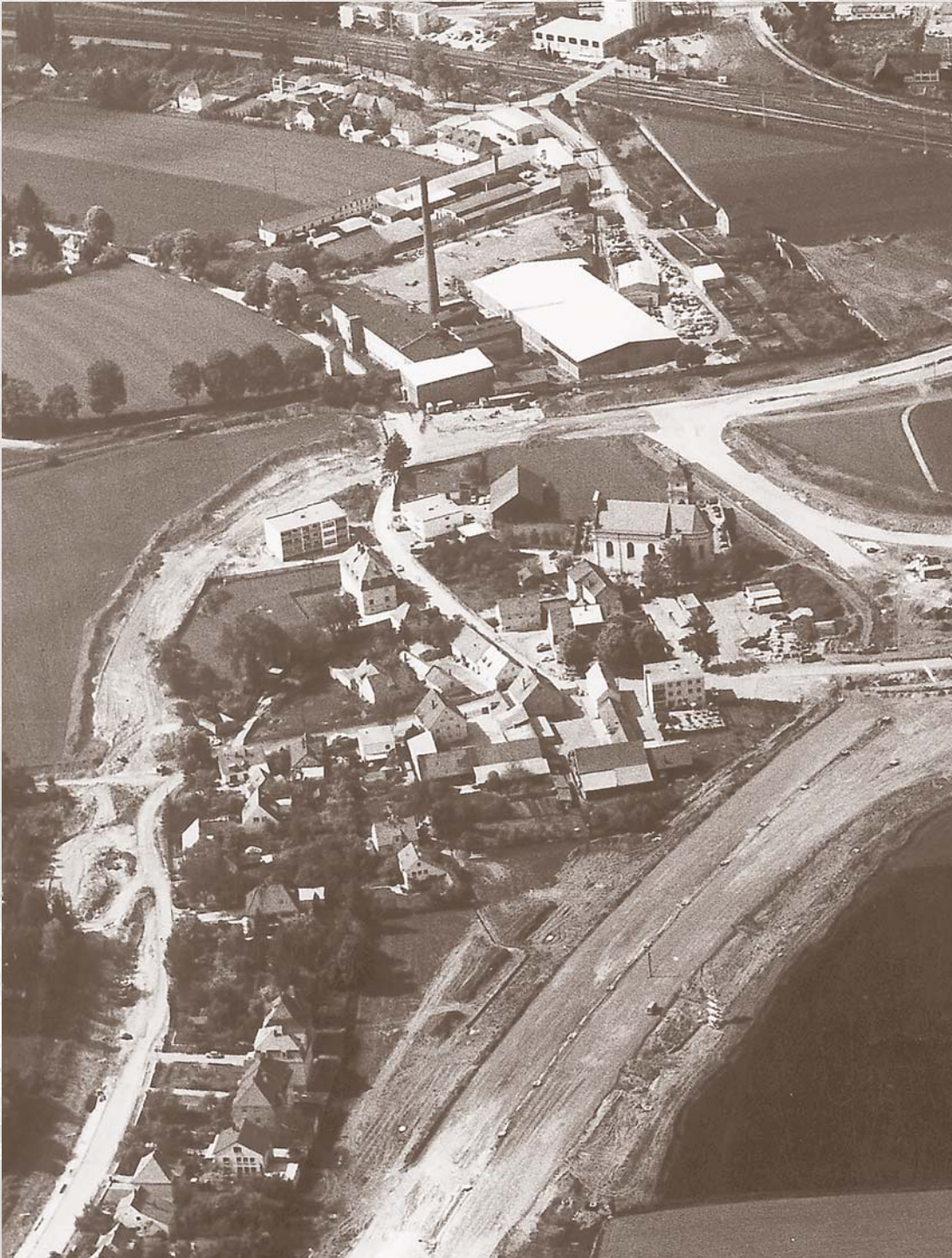
1971: Dechbetten, während des Baus der Westumgehung (heute A93)
