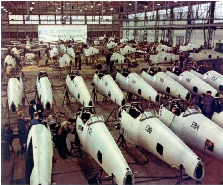
Blick in die Endmontage der Bf 109 in Regensburg 1940. Foto: Messerschmitt AG Augsburg
