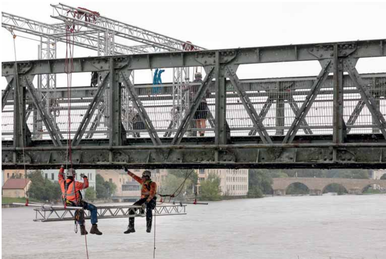
Bauwerksprüfung des Eisernen Stegs 2025 Foto: Bilddokumentation Stadt Regensburg
