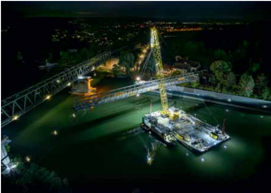
Einhub der Geh- und Radweg- brücke Sinzing 2023 Foto: Bilddokumentation Stadt Regensburg
